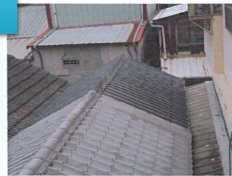
屋頂完成外觀
